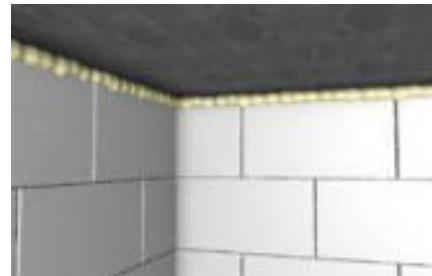
Uszczelnianie złączy liniowych
