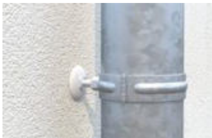
Mocowanie rury spustowej do izolacji za pomocą kołka FID-R
