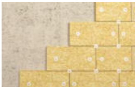
Wełna mineralna mocowana do betonu
