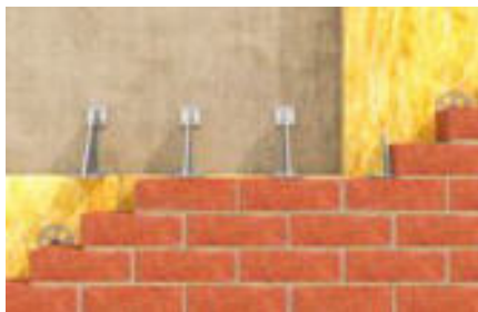
Materiały izolacyjne pomiędzy warstwowymi ścianami zewnętrznymi
