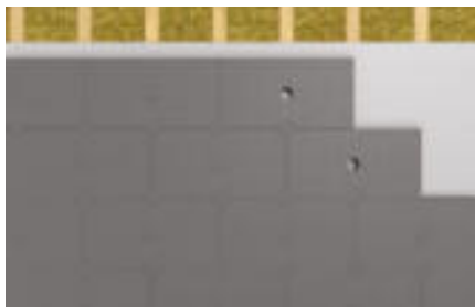
Mocowanie płyt styropianowych na podkonstrukcji drewnianej
