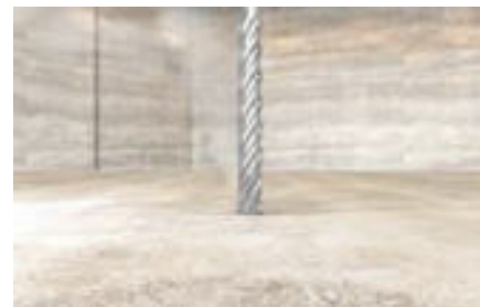
Wiercenie w podłożu betonowym
