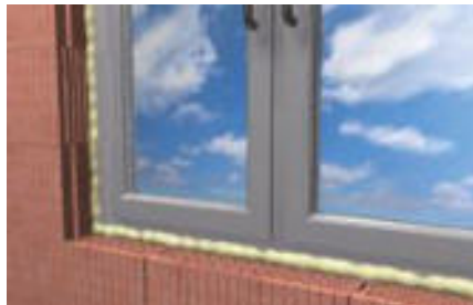
Uszczelnianie ościeżnic okiennych i futryn
