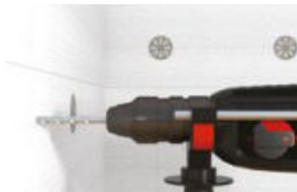
Montaż płyt styropianowych
