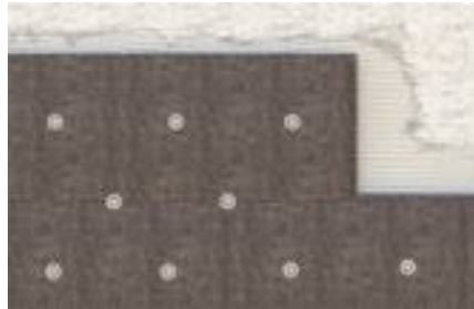
Kołek TermoZ CN mocujący płyty styropianowe do podłoża ze starym tynkiem
