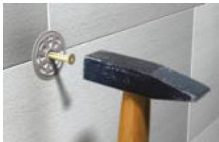
Montaż równo z powierzchnią płyt
