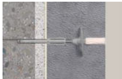
Montaż z dużym zagłębieniem kołka płyt styropianowych do podłoża betonowego
