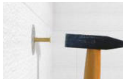
Montaż kołka wbijanego poprzez płytę styropianową
